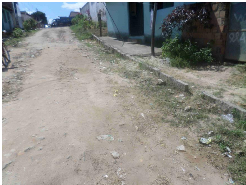
Foto 1 – Trecho a ser pavimentado Rua Álvaro Pinto Ribeiro
