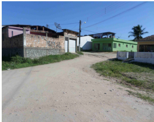
Foto Rua Hermínio Apolônio - Trecho à Pavimentar
