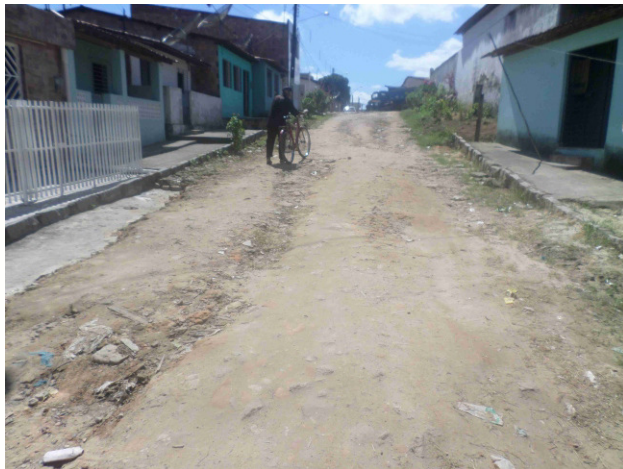
Foto Rua Álvaro Pinto Ribeiro - Trecho à Pavimentar
