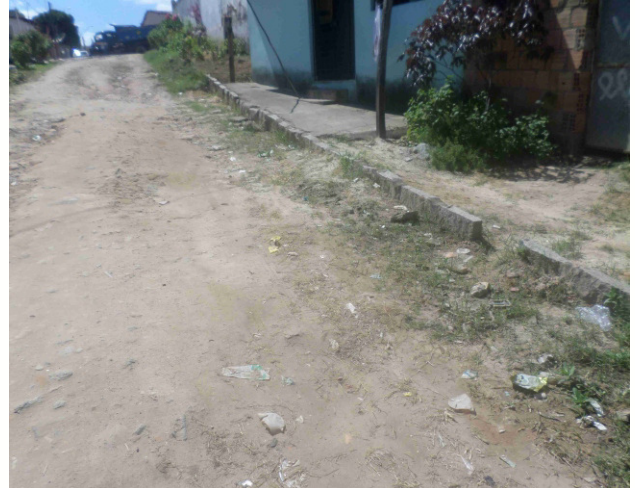
Foto Rua Álvaro Pinto Ribeiro - Trecho à Pavimentar
