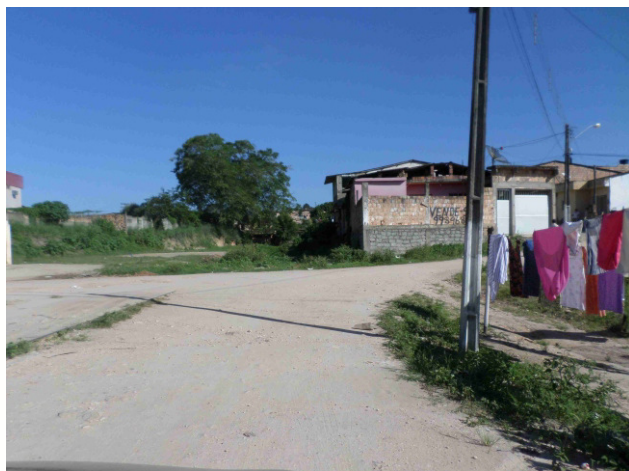
Foto Rua Hermínio Apolônio - Trecho à Pavimentar
